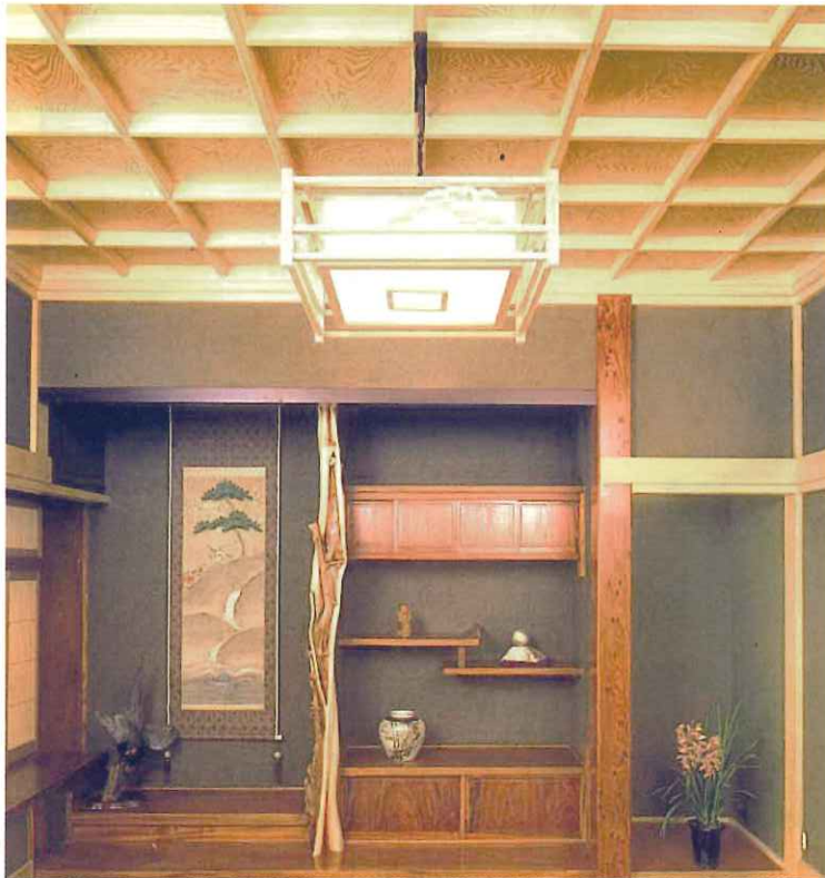
平格天井施工例
