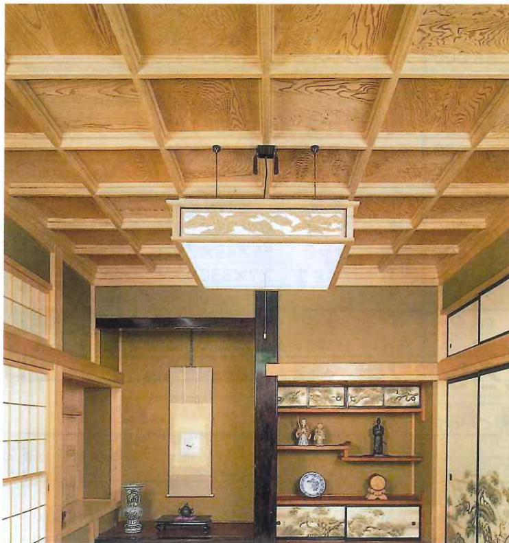
付け子の上に二重廻縁と二重竿の施工例です。
