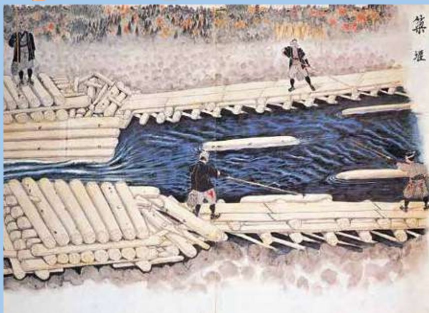
△築堰：本谷に、木材を組んで造る堰のことで、要所、要所に造って集めた木材をスムーズに下流へ流す役目をします。
