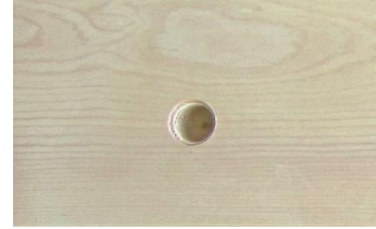
棚板の吊棒仕口
